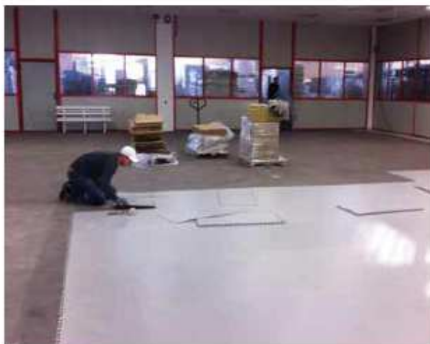
La fase di posa / Installation phase
