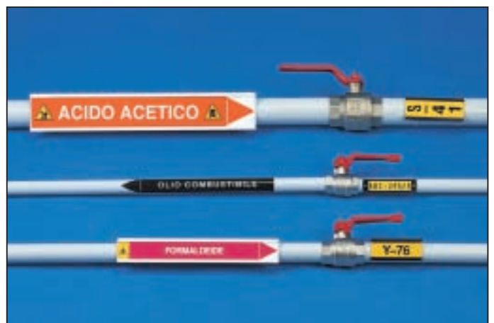
tubazioni con sistema TLS
